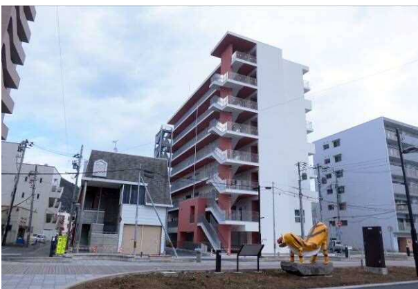
【東部地区大町復興住宅3号棟】
