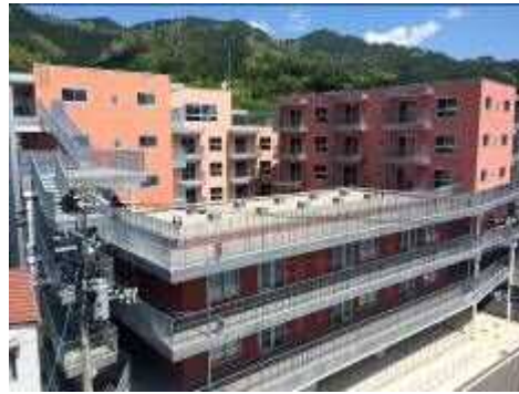
大町復興住宅1号棟 (H.28.4 竣工)
