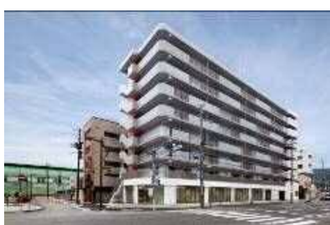
大町復興住宅4号棟 (H.28.9 竣工)
