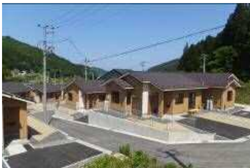
荒川復興住宅 (H.28.5 竣工)
