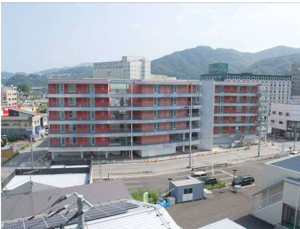
【東部地区只越復興住宅1号棟】
