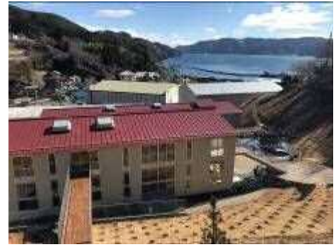
唐丹地区学校（H.29.2部分竣工）
