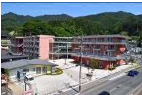
天神復興住宅 (H.28.6 竣工)
