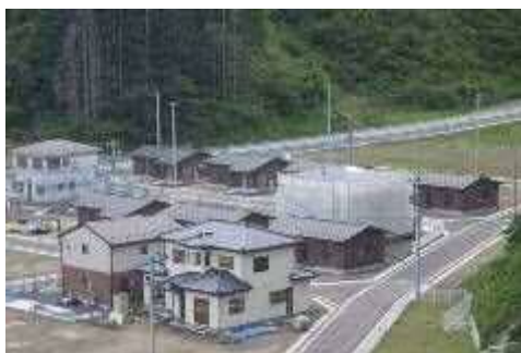
室浜復興住宅 (H.28.6 竣工)
