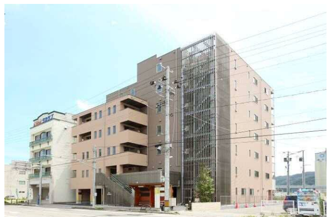
【東部地区只越復興住宅4号棟】
