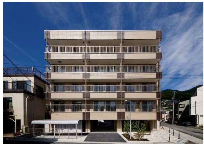
【東部地区只越復興住宅2号棟】
