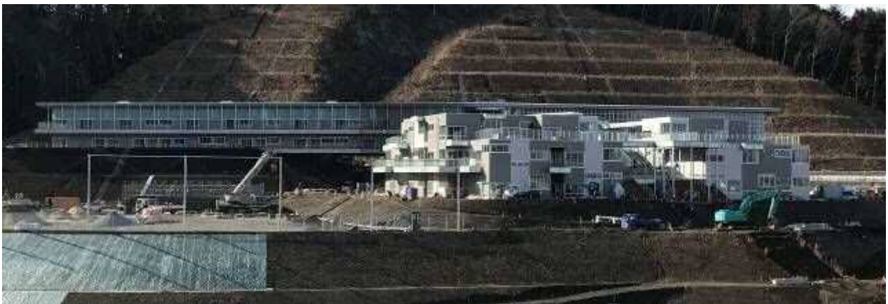
鵜住居地区学校（H.29.3竣工）※H29.1撮影
