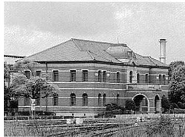
官営八幡製鐵所旧日本事務所
