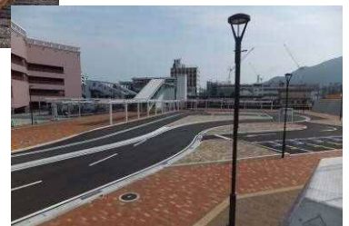
写真 城野駅南口駅前広場の整備
