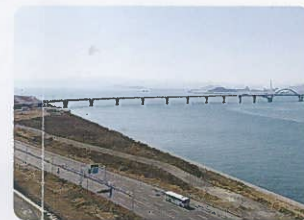
北九州空港連絡橋を渡ると約5分で東九州自動車道に入る
