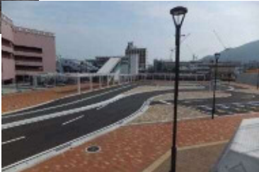
写真 城野駅南口駅前広場の整備
