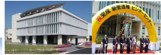
日明浄化センター新管理棟（ビクターセンター）
