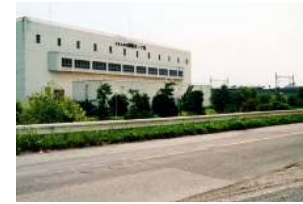
櫛橋ポンプ場
