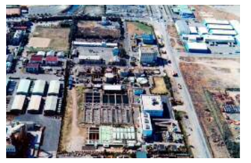
北湊下水処理場運転開始
