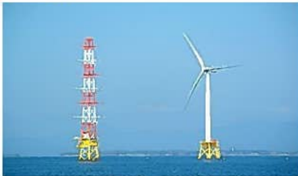
写真 洋上風力発電
