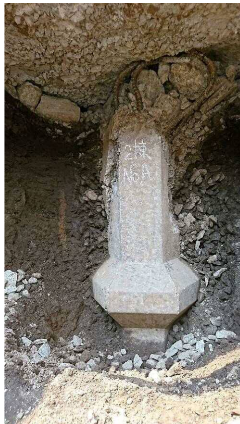
町営総領団地 杭破損
