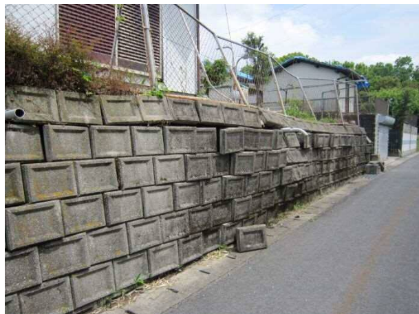
崩壊寸前の練積み擁壁
