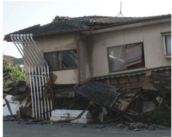
1階が崩壊した住宅
