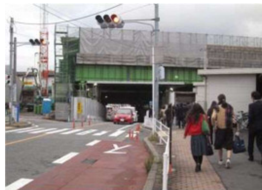
工事桁架設状況
