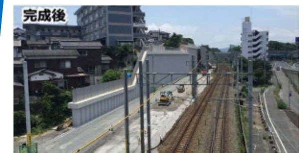
変更：鋼管杭直壁工法
