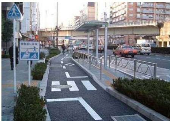
■交通島を設置し、道路標識及び道路標示を設置した事例
