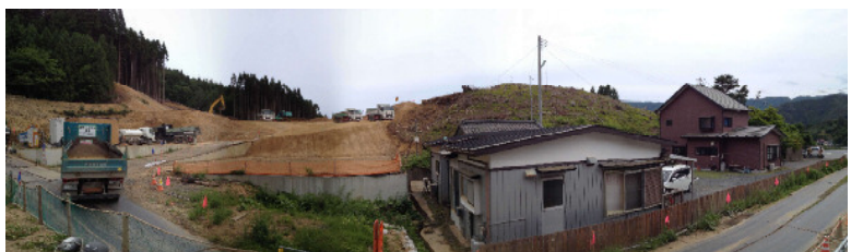
小白浜地区東側造成地（荒造成後）
