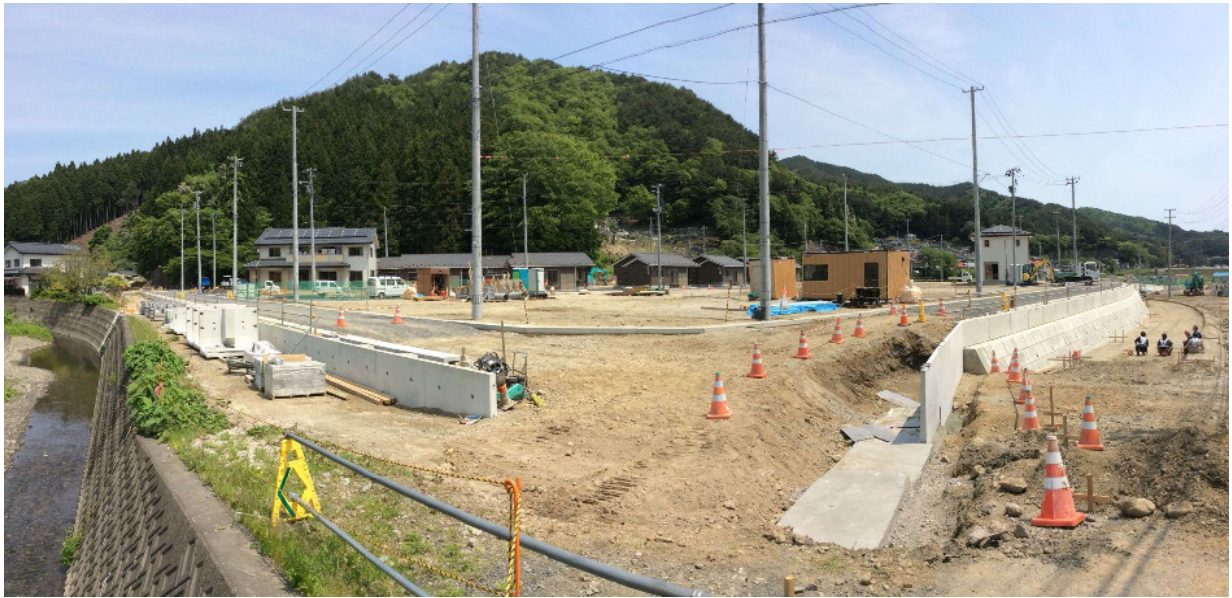
本郷地区（造成地完成直前）
