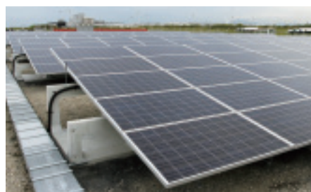
【太陽光パネルのリサイクル】
