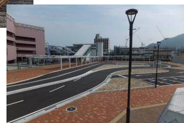
写真 城野駅南口駅前広場の整備
