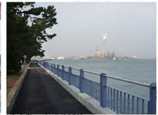
延命寺遊歩道安全柵の整備
