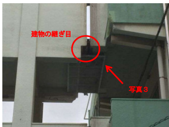
写真2 建物の継ぎ目
