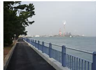
延命寺遊歩道安全柵の整備
