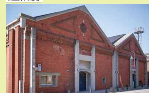
大正2(1913)年竣工。工場設立当時の煉瓦造倉庫。切妻部分の装飾は続き棟のように作られていますが、独立した構造になっています。平成18(2006)年にコミュニティホールとして再生され、地域のまちづくりのために利用されています。
