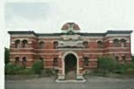
官営八幡製鐵所旧本事務所
