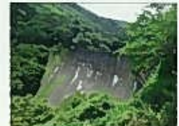
河内貯水池の堰堤
