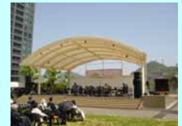
門司港レトロ多目的広場の整備
