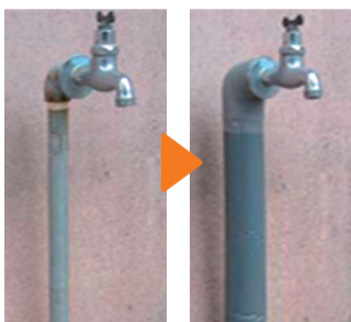
保温チューブの取付
