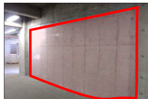
(耐震化後)中空部に耐震壁設置
