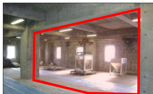
(耐震化前)耐震診断により、補強箇所を選定
