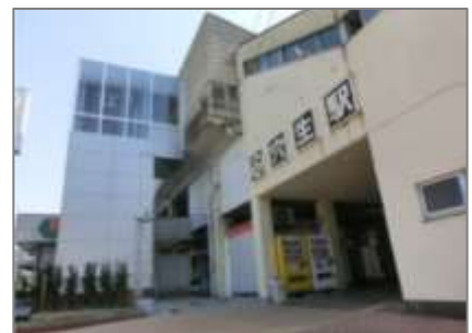
■写真一3 エレベーターの設置 (筑鉄穴生駅)
