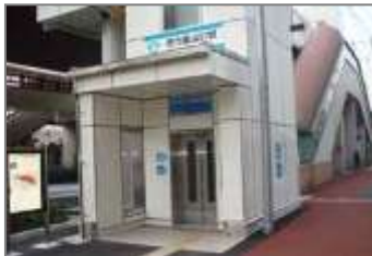
■写真-3 エレベーター（徳力嵐山口停留場）
