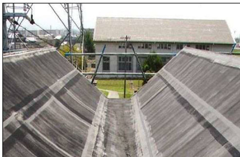
ポンプ棟屋上防水前
