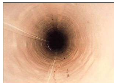
修繕後:管更生
