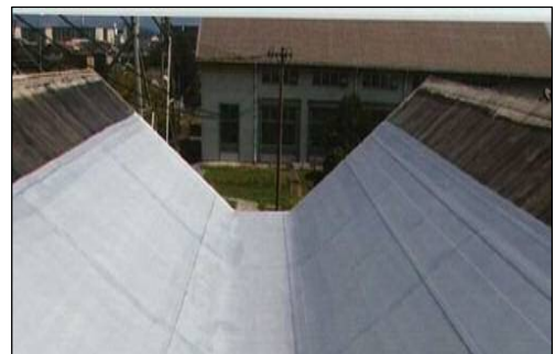
ポンプ棟屋上防水後
