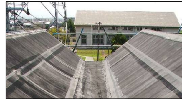
(ポンプ棟屋上防水前)
