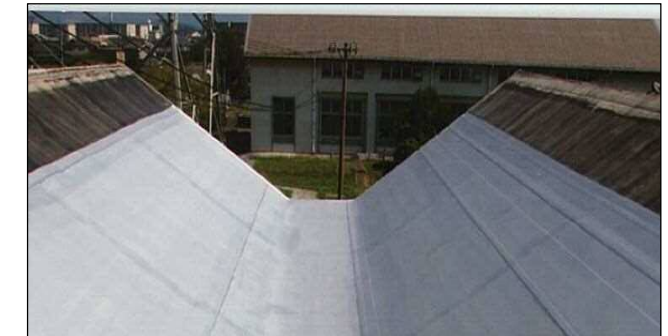
(ポンプ棟屋上防水後)
