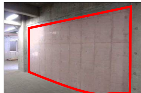
(耐震化後)中空部に壁面設置
