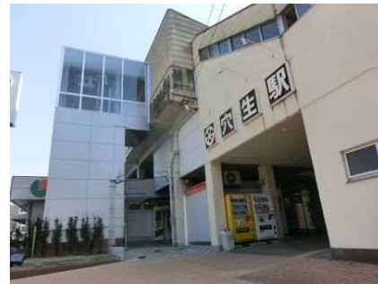
筑鉄穴生駅エレベーター設置
