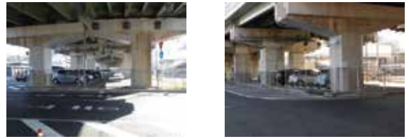
見通しの良い敷地境界（フェンス等）
