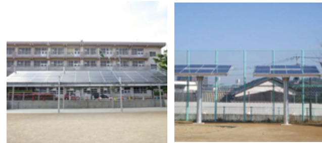
太陽光発電設備(出力10kWの設置例) 太陽光発電設備(出力3kWの設置例)
