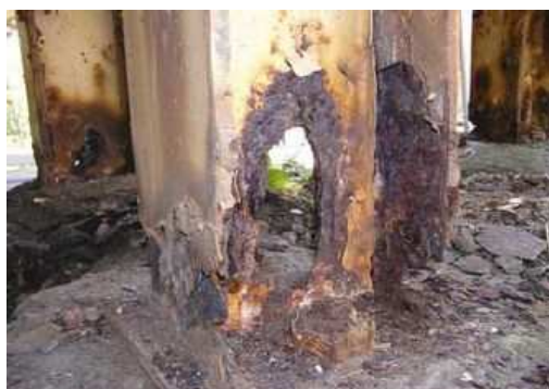
腐食片を取り除いた状態の例（下部）
