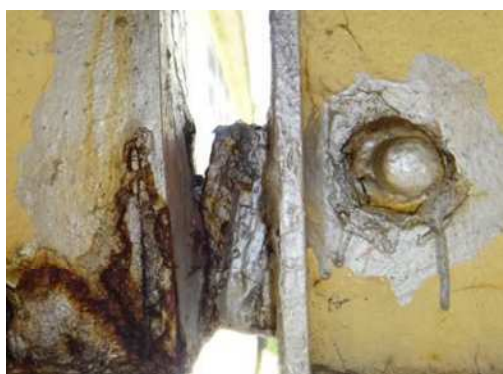
フックの溶接の状態（接合部）
