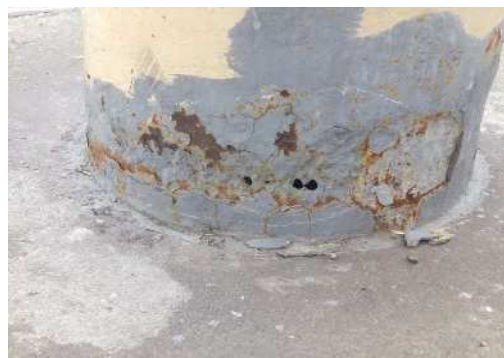
腐食片を取り除いた状態の例（下部）
