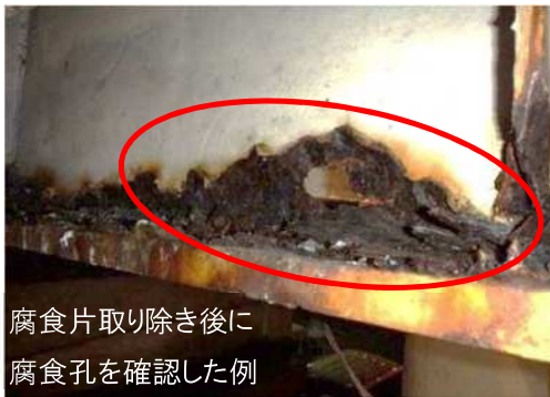
腐食片を取り除いた状態の例（主桁）
