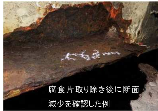
腐食片を取り除いた状態の例（主桁）
