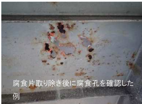
腐食片を取り除いた状態の例（床版）
