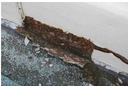
腐食片を取り除いた状態の例（地覆部）
