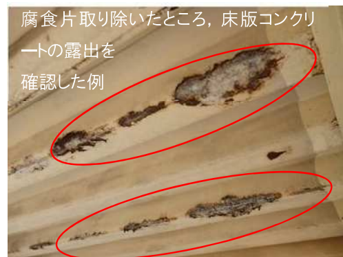
腐食片を取り除いた状態の例（床版）
