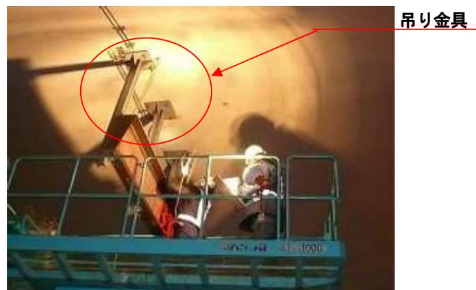
写真-解 6.3 触診作業状況
