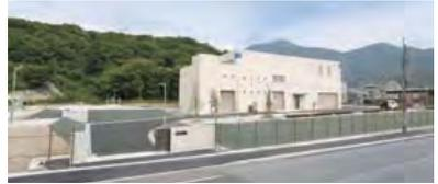
藤田ポンプ場は、JR黒崎駅周辺に降った雨水を排水するため昭和38年に運転を開始していましたが、近年の豪雨に対する排水能力が不十分となり、浸水被害の解消と合流式下水道の改善を同時にはかるため、新たに雨水ポンプ場を城山緑地内に建設し、平成24年度に供用を開始しました。
