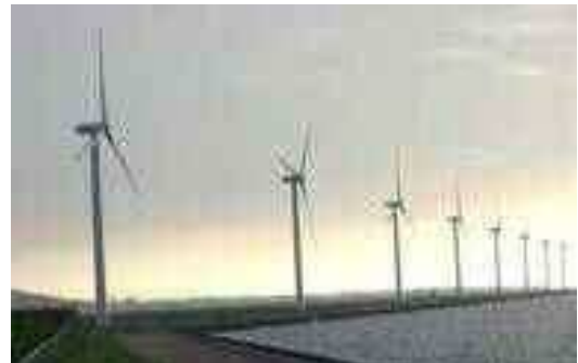
響灘風力発電施設
