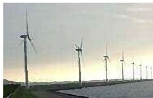
響灘風力発電施設
