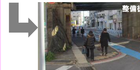
▲国道322号<歩道拡幅>
