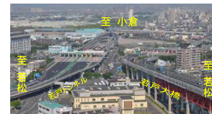
▲若戸トンネル<新規道路整備>
