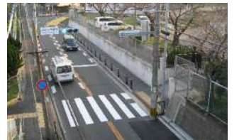
▲通学路の交通安全対策(横断歩道、歩道拡幅、防護柵等の整備)
