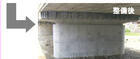
▲下道津橋<橋脚補強>
