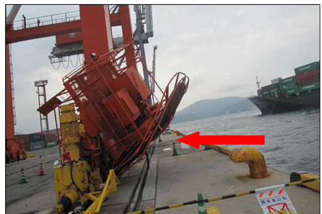
大破したケーブルリール
