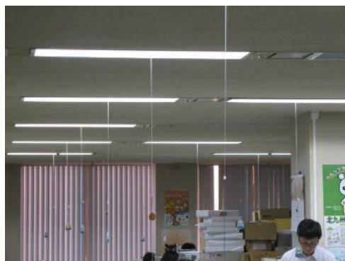
市役所本庁舎・区役所等において引き紐スイッチを設置
