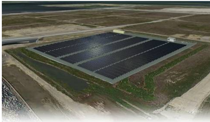
市民太陽光発電所（メガソーラー）【若松区響町】
