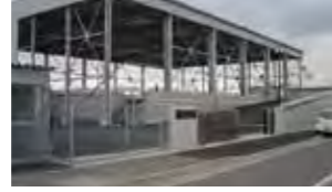
北九州市エコタウンセンター廃棄物研究施設
