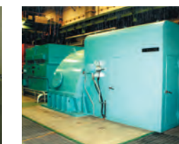
廃棄物発電 ・皇后崎工場（36,340kW）
