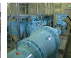
小水力発電 ・穴生発電所（340kW）
