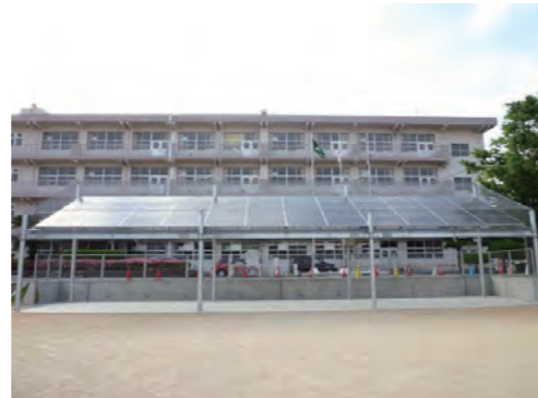
太陽光発電設備（出力10KWの設置例）
