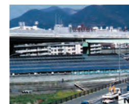
太陽光発電 ・紫川水源池（150kW）
