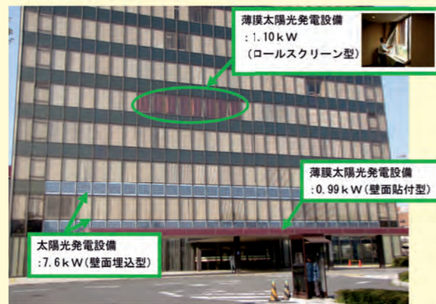
市役所本庁舎太陽光発電設備
