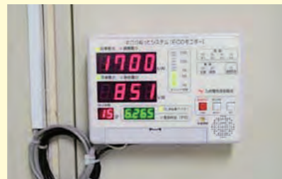
デマンドコントローラーの設置
