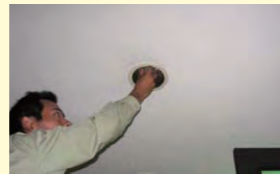
白熱電球のLED照明への更新
