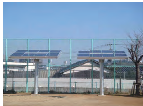
太陽光発電設備（出力3KWの設置例）
