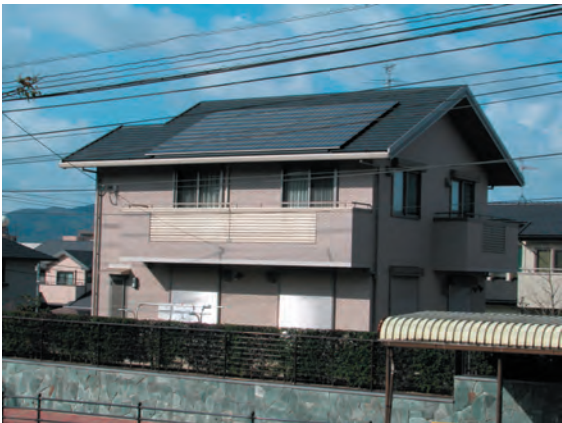
住宅用太陽光発電システム
