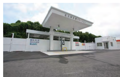
北九州水素ステーション
