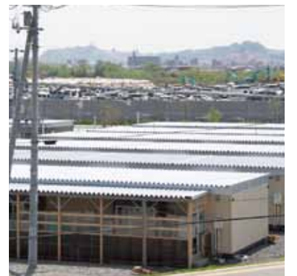
仮置場に隣接する仮設住宅
