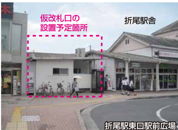
■ 折尾駅東口 仮改札建築工事
