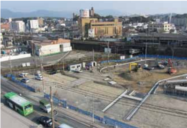
■ 暫定北口駅前広場 工事状況
