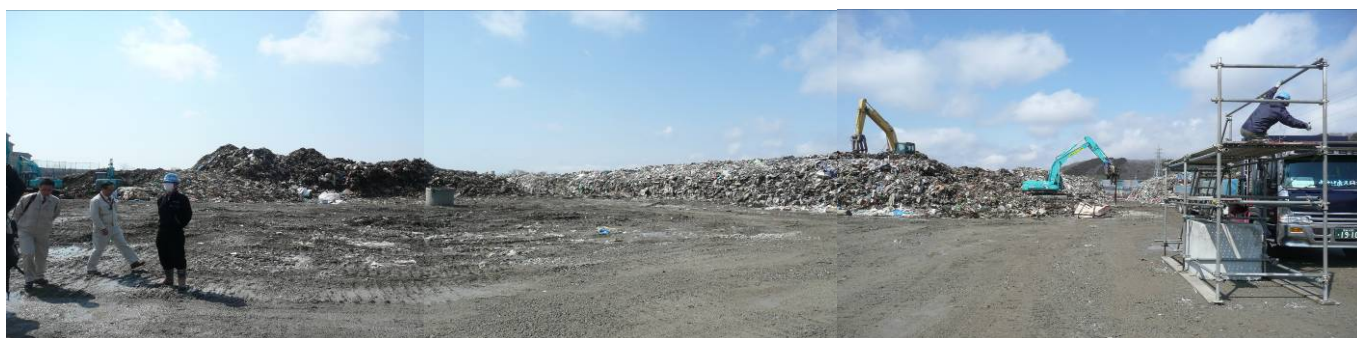
〔南境一次仮置場・全景〕
