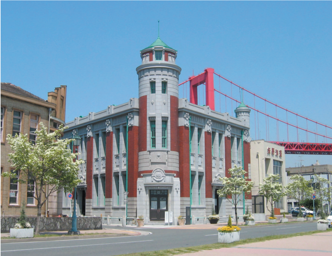
旧古河鉱業若松ビル
