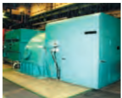
廃棄物発電 ・皇后崎工場(36,340kW)
