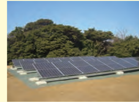
水道局配水池
