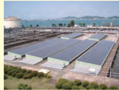
日明浄化センター
