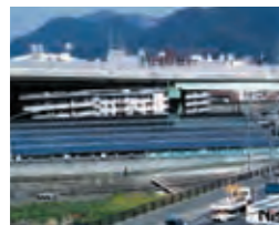
太陽光発電 ・紫川水源地(150kW)
