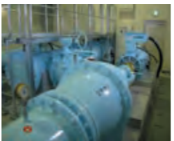
小水力発電 ・穴生発電所(340kW)
