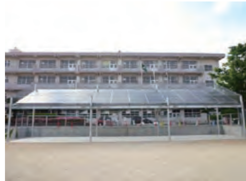
太陽光発電設備（出力10KWの設置例）
