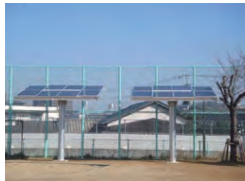
太陽光発電設備（出力3KWの設置例）
