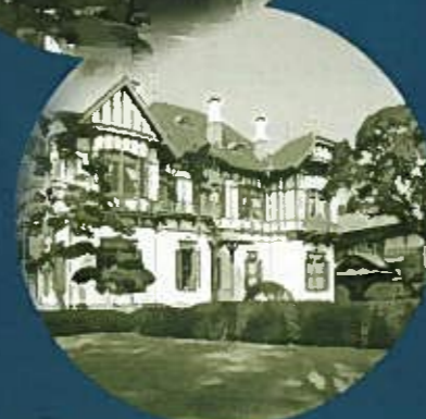
旧松本家住宅 1912年竣工
