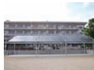
太陽光発電設備の設置例（出力10kW）
