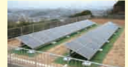
水道局配水池
